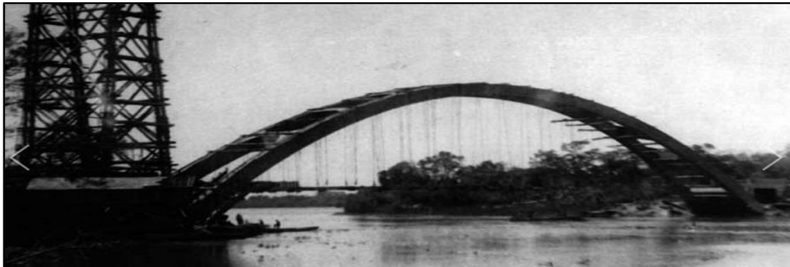
Figura 2 - Construção do arco da ponte Novo Oriente
