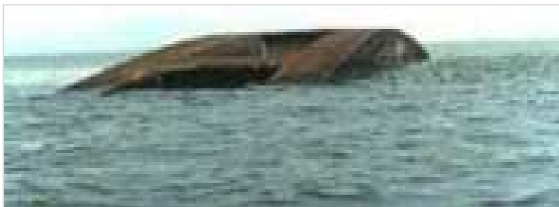
Figura 4 – Ponte Novo Oriente na fase final do alagamento em 1990
