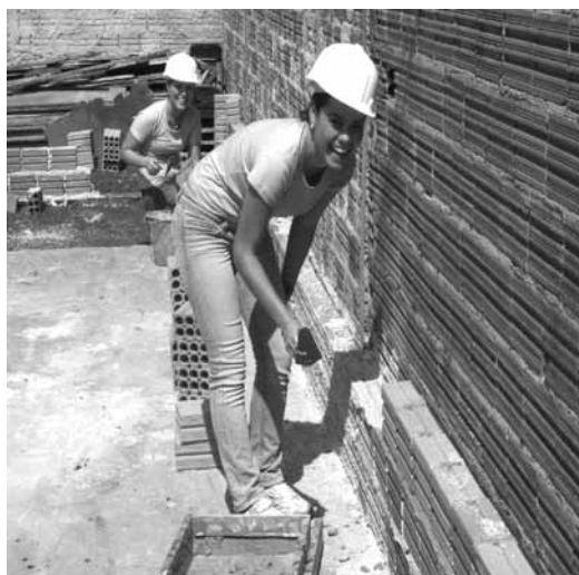
Fonte: Arquivo pessoal da autora Figura 11 – Alvenaria
