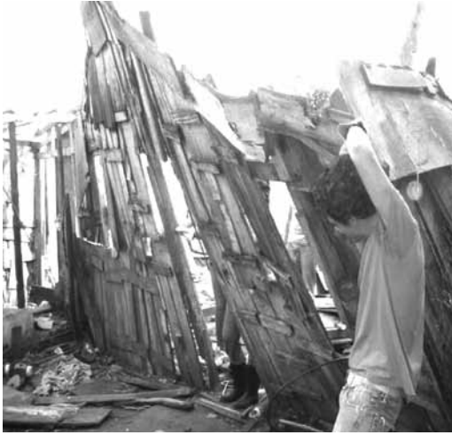
Fonte: Arquivo pessoal da autora Figura 7 – Demolição de 2008
