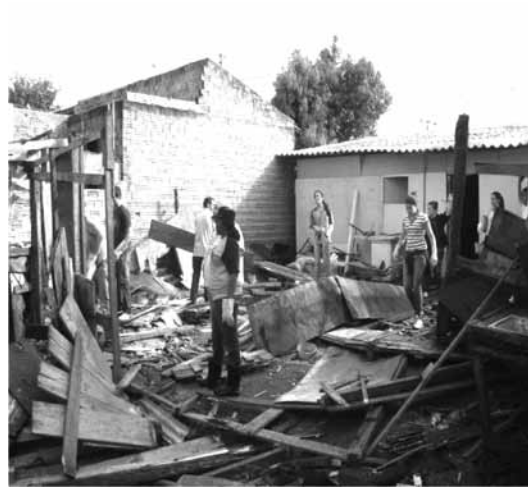
Fonte: Arquivo pessoal da autora Figura 8 – Demolição de 2008
