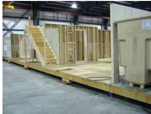
FIGURA 03 Casas Pré-Fabricadas: Linha de montagem FONTE: Casa Pré-Fabricada
